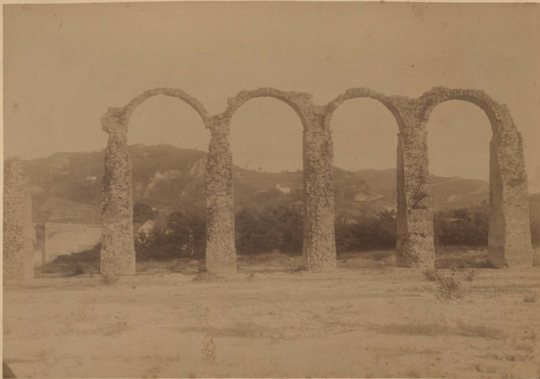
ACQVEDOTTO ROMANO D'ACQVI LATO NORD PRIMA DEL RESTAVRO
