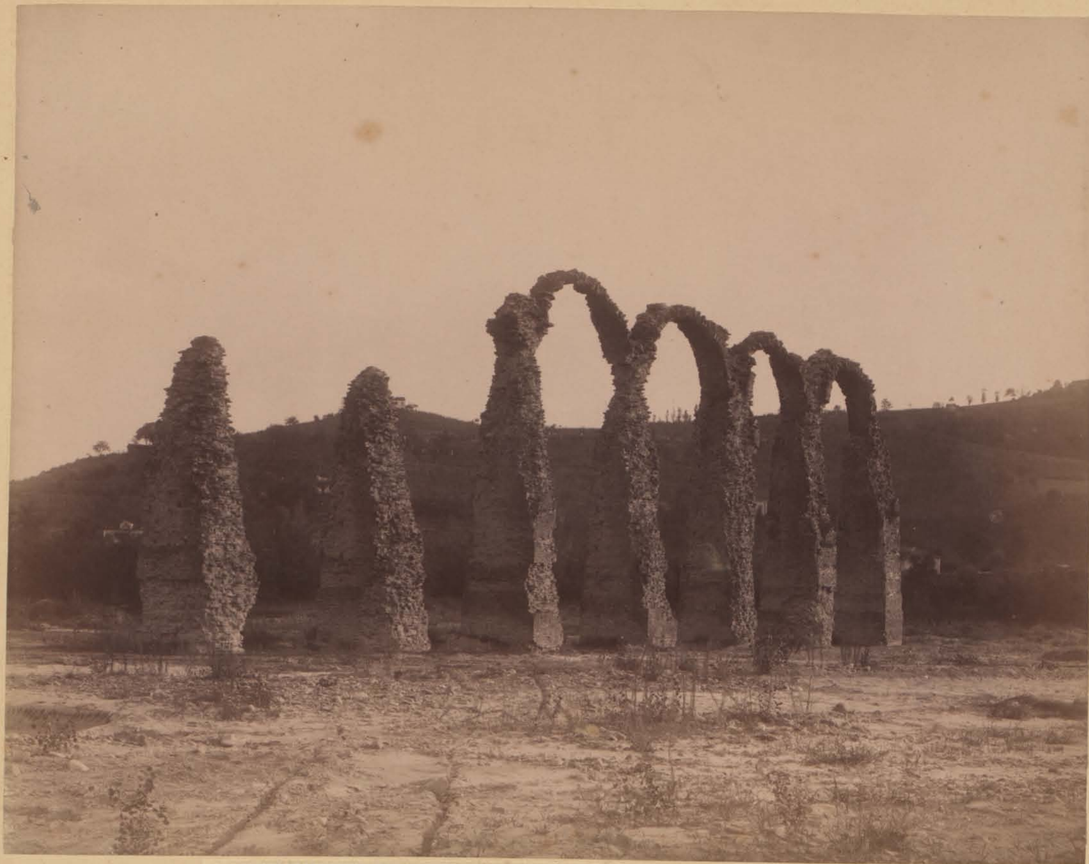
ACQVEDOTTO ROMANO D'ACQVI - LATO NORD PRIMA DEL RESTAVRO
